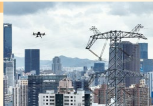
输电运维人员利用大型多旋翼无人机开展精细化巡视
