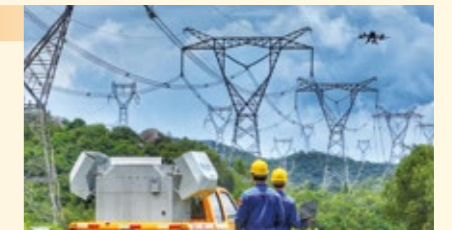
输电线路运维人员对 400 千伏核深线进行特巡特维
